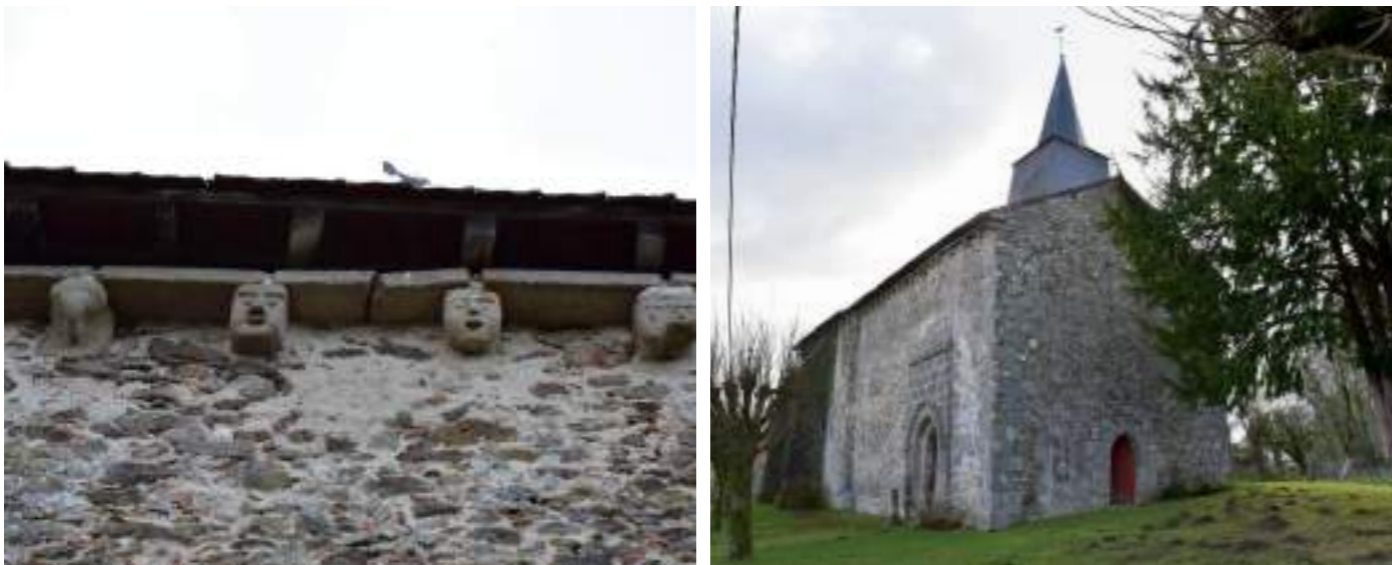
Photographie 160 : Détail des modillons et vue d'ensemble de l'église Sainte-Madeleine.
